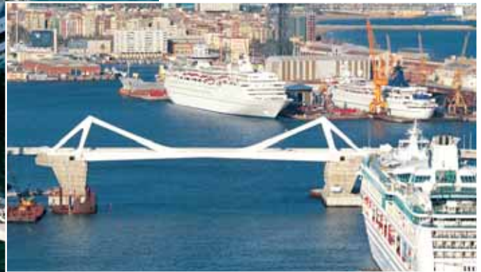
巴塞罗那。当今世界上最大的双扇开阖式活动桥，赖以转动的是无需维修保养的大型肘式轴承，其穿孔直径为 670 毫米。
