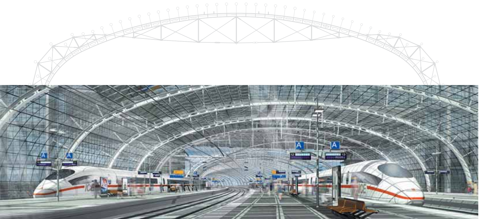
柏林列尔特车站：这是欧洲规模最大的车站屋顶结构建筑，它覆盖在大约 300 米的月台上，结构中融入许多 ELGES - 关节轴承/支承系统（计算机仿真图、柏林 Archimation 公司版权所有）。
