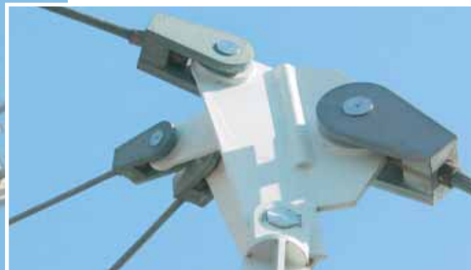
金属丝线编织而成，但有极大的承载力：屋顶结构由钢索吊接。
