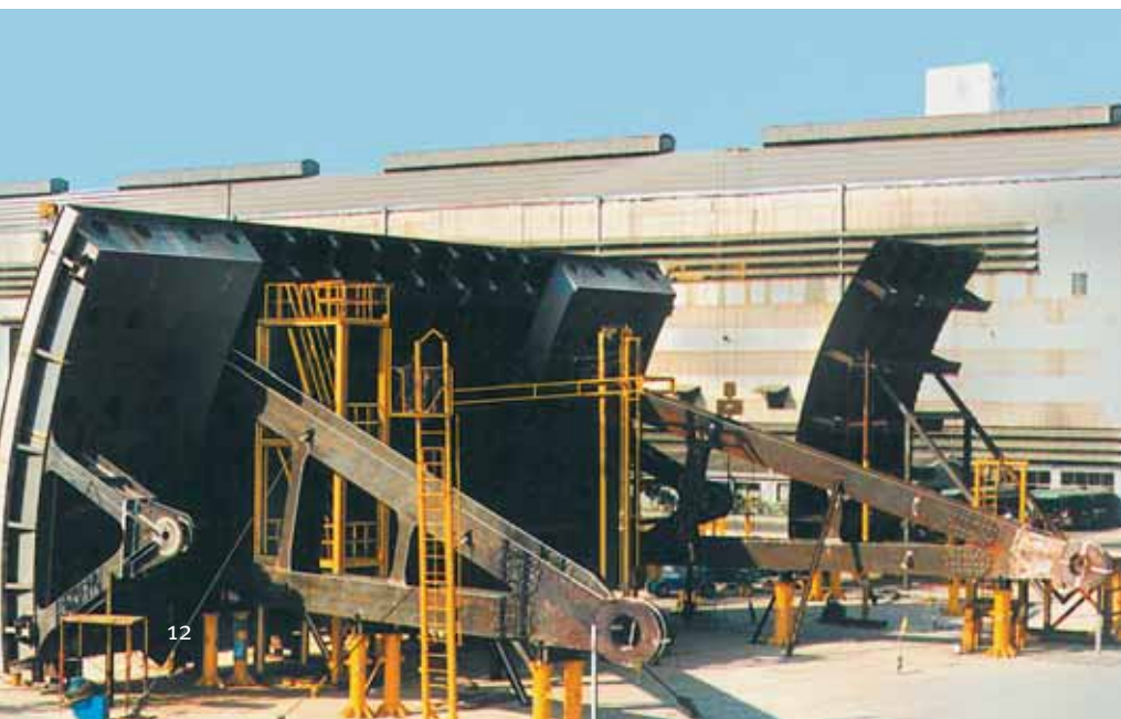
巨无霸：新万锦拦水坝的拦水段挡板，高 15 米、宽 30 米。
