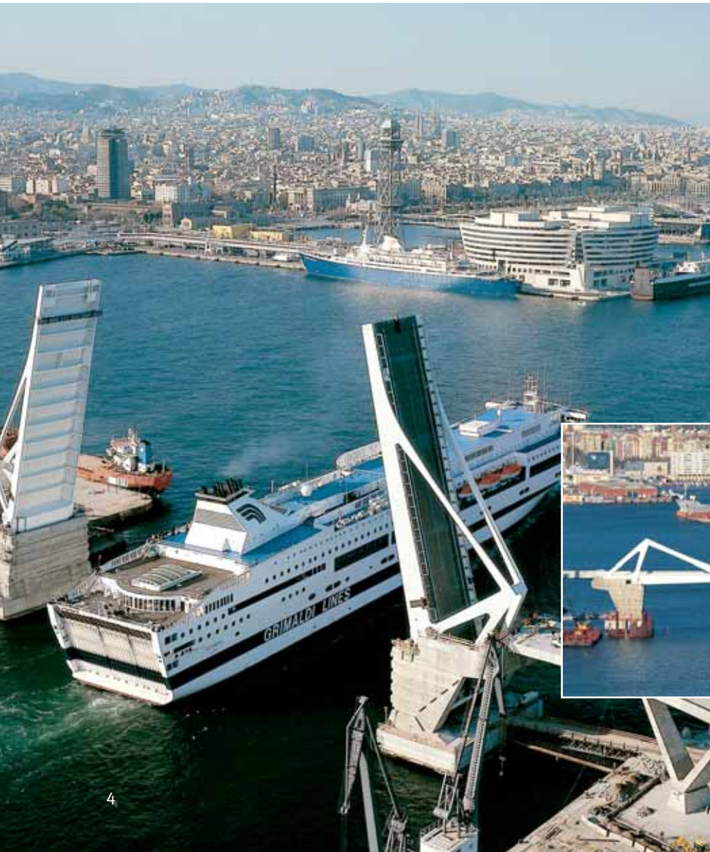
巴塞罗那。当今世界上最大的双扇开阖式活动桥，赖以转动的是无需维修保养的大型肘式轴承，其穿孔直径为 670 毫米。
