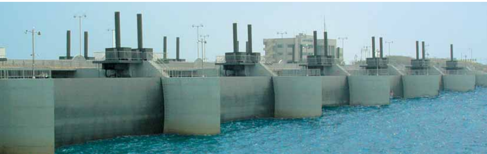
韩国的新万锦拦水新生地：这座 2001 年建成的拦水坝是一项众所瞩目的大工程，同时也是 ELGES 产品展露头角最令人感到兴趣的范例。
