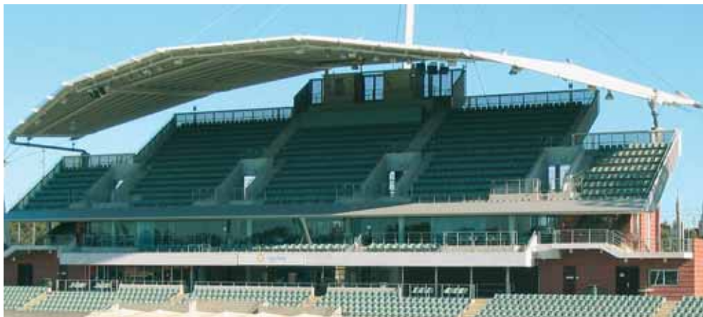
悉尼的国立曲棍球中心：屋沿和柱子上所有的钢索铰接点全部都由经过 ELGOGLIDE®表面涂层处理的关节轴承轻松地承受着。
