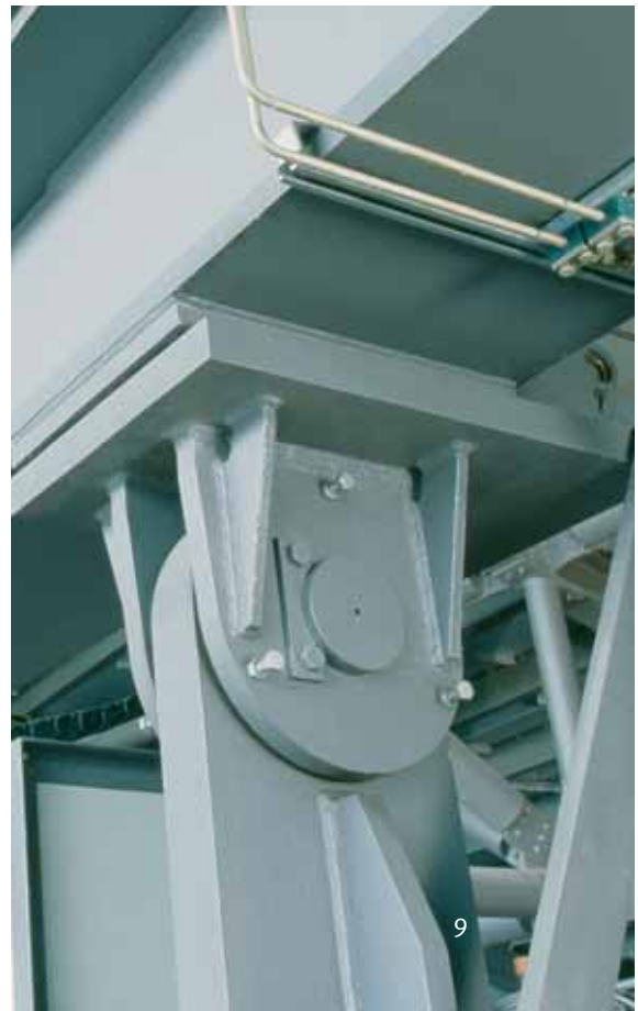
看台下支柱上的肘式轴承：在草坪拉进拉出时，要竖起肘式轴承。
