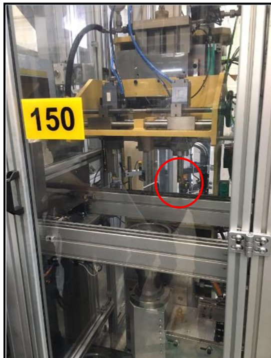
图 5-3 同类工程注油脂现场照片
